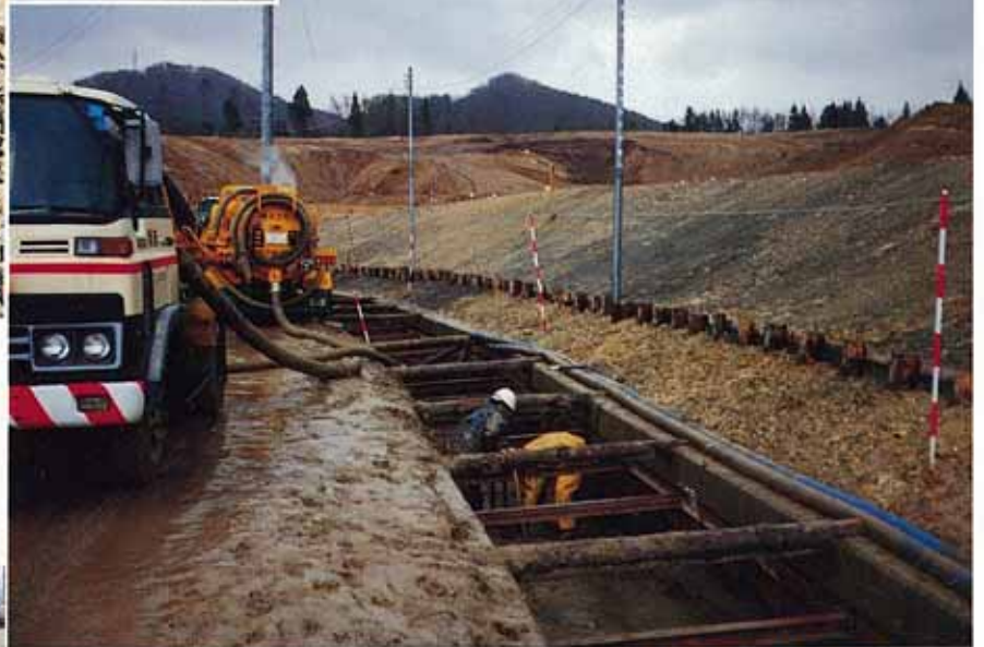
▲ 地下LPGタンク廻りの砂入換作業状況
