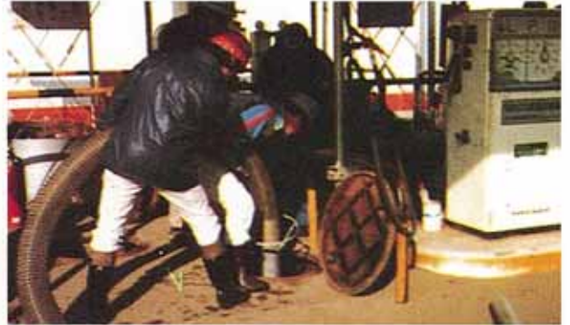
▲ 地下LPGタンク廻りの砂入換作業状況
