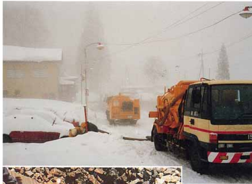
▲ 地下LPGタンク廻りの砂入換作業状況
