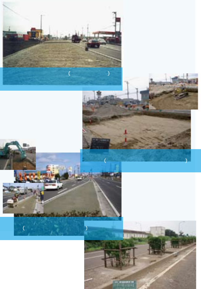
直江津8号・18号維持工事 防草材(国道中央分離帯植樹帯試験フィールド事業) 国土交通省
